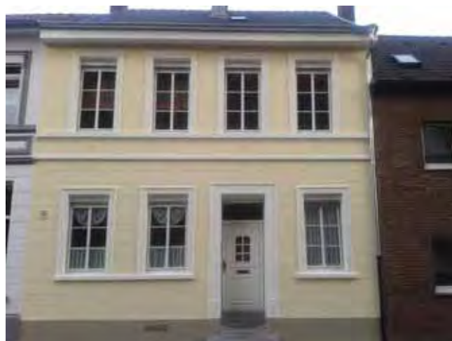
Abbildung 8 Modernisiertes Wohnhaus Kreuzherrenstraße
