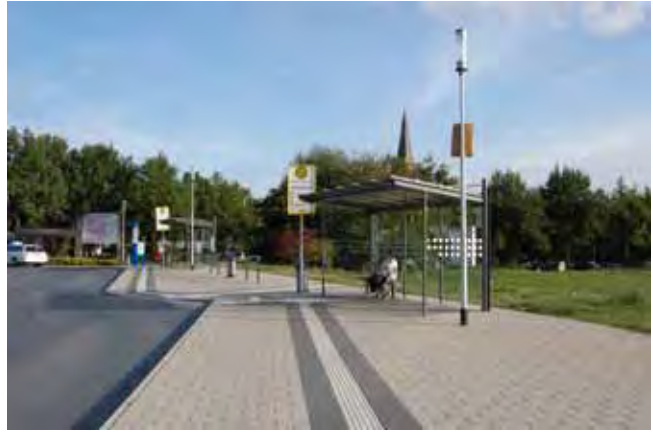
Abbildung 27 Neuangelegter zentraler Busumsteigepunkt
