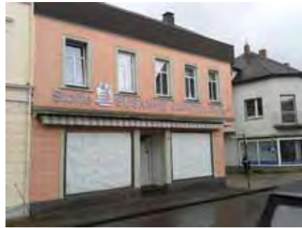
Abbildung 95 Fassade Marktstraße 7, vor dem Umbau (oben) und nach dem Umbau (unten)
