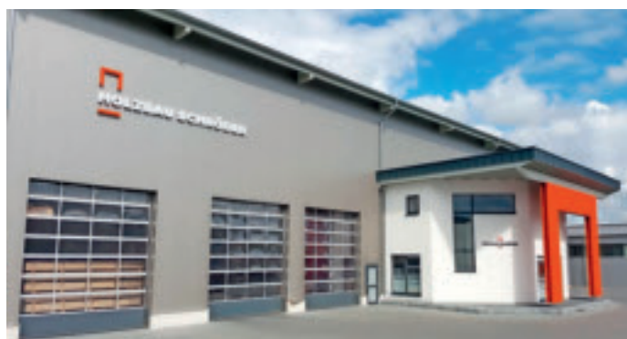
Die Produktionshalle von Holzbau Schröder in Niederkrüchten.
