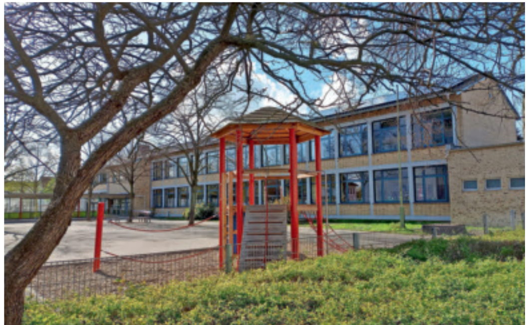
Das Schulgebäude der GGS Rahser an ihrem Hauptstandort Regentenstraße.
