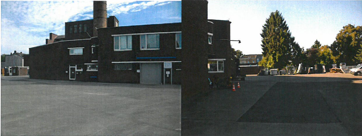
Abb. 6: Verkehr-, Park- und Abstellfläche westlich der Sheddachgebäudes. Bild links: Blick nach Osten auf den Kamin und Geb. 1, rechts Einfahrt zu den Gewerbehallen der Fa. Schmitter und Meertz Metallbau. Links neben der Tür Standort RKB 33, hinter der rechten Tür im Durchgang RKB 37.2. Bild rechts: Blick nach Süden, links Standort RKB 33
