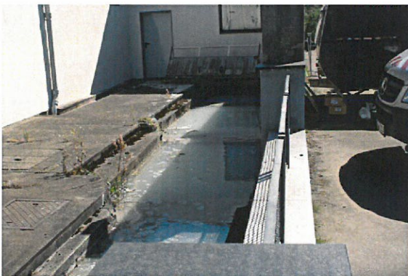
Abb. 9: Wasserbecken auf dem Nachbargrundstück an der östlichen Grundstücksgrenze unmittelbar an der RKB 50
