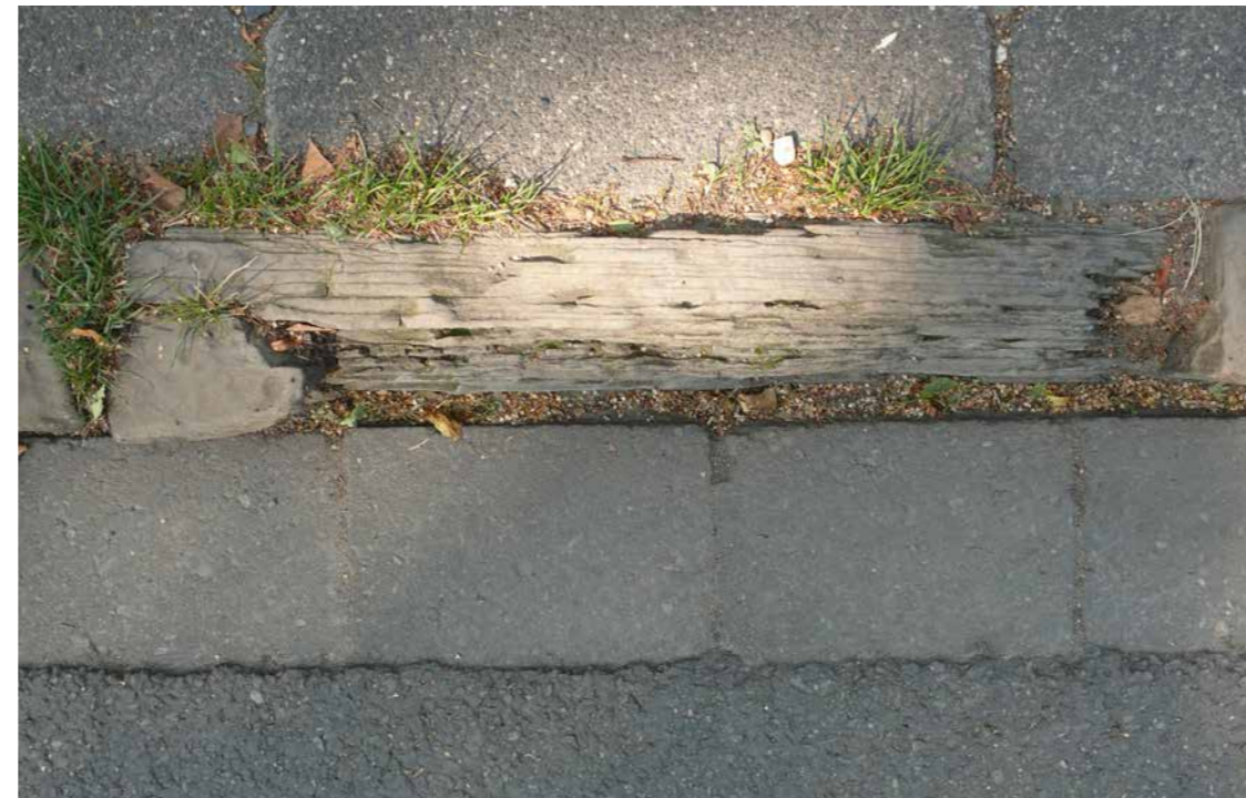
Beschädigte Bestandseinfassung wird ausgetauscht
