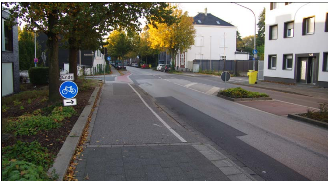
Bild 3: Auflösung des Zweirichtungsradwegs Süchtelner Str.
