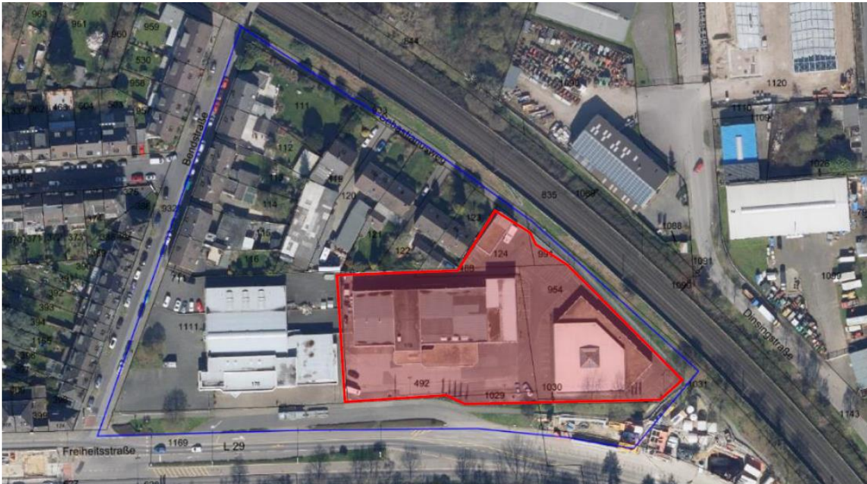
Abb. 3: Luftbild des Planbereichs
