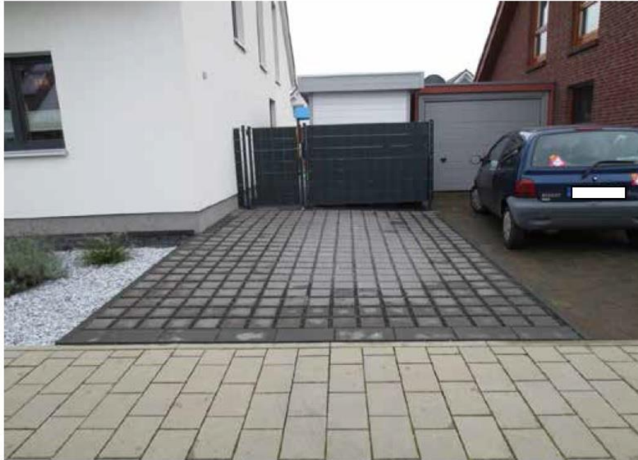
Stellplatz: Pflaster mit durchlässigen Fugen → „stark versiegelt“
