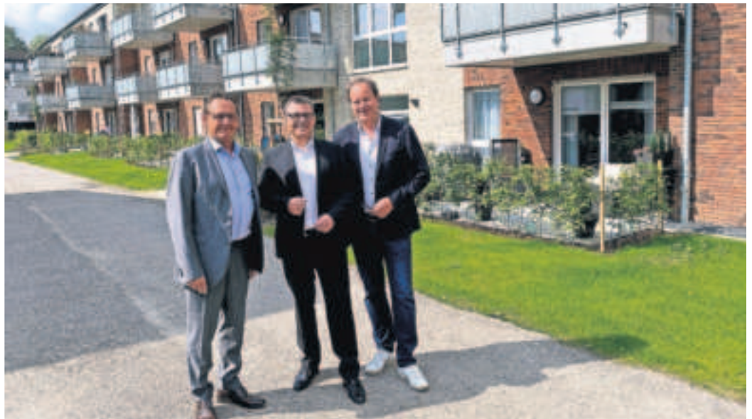
125 Jahre Bauverein Dülken: Die Vorstandsmitglieder Michael Lambertz, Bernd Ivangs und Christoph Saringen (v. l.) – hier vor dem kürzlich abgeschlossenen Neubauprojekt am Ostgraben – laden am 1. Juni zum großen Mitglieder- und Familienfest. Foto: Bauverein
