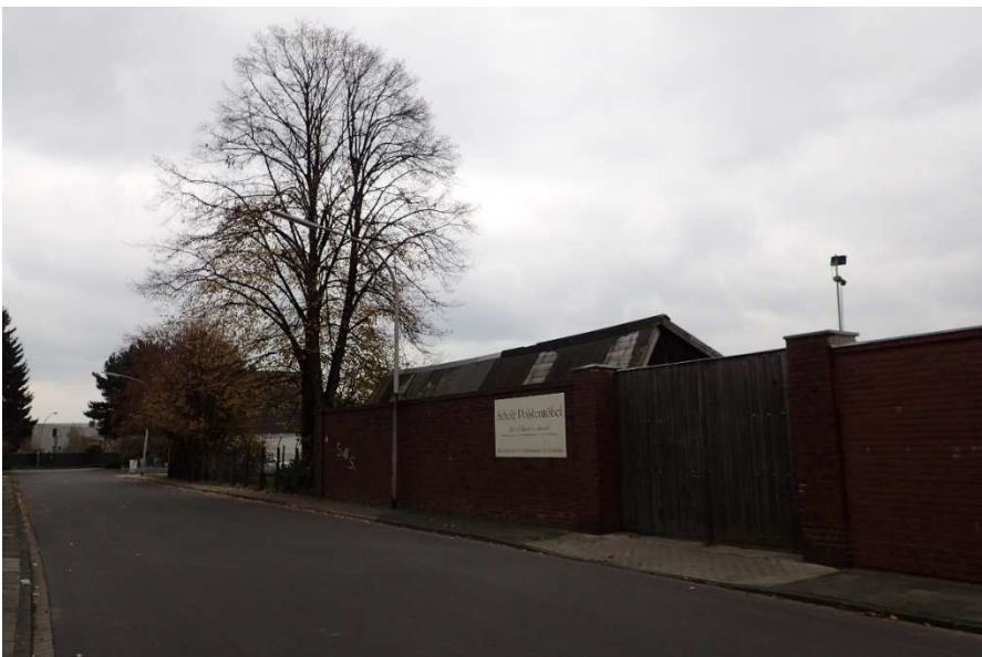
Abb. 2b: Gelände von der Straße aus gesehen, im Hintergrund eine Linde
