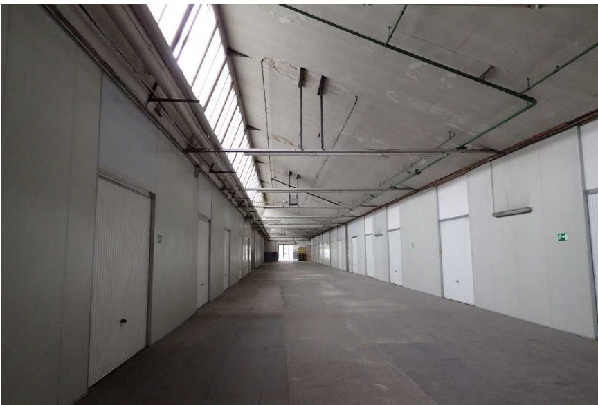
Abb. 2a: Hallen (Innenraum)
