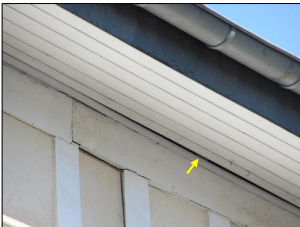
Abbildung 4: Dachvorsprung mit Spalt / Bewuchs im Innenhof
