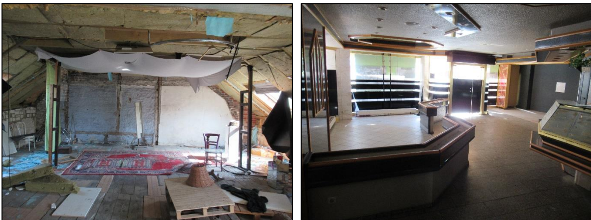
Abbildung 13: Ehemaliger, dichter Dachboden / ehemalige Bäckerei
