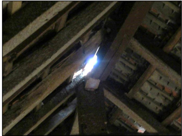
Abbildung 14: Ehemaliger Schlecker / Dachboden mit undichtem Dach
