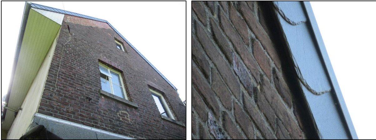
Abbildung 8: Dachumlauf aus Schieferschindeln mit Spalt
