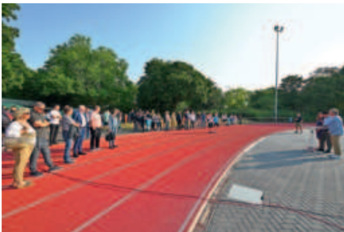
Die Kunststofflaufbahn wurde saniert.
