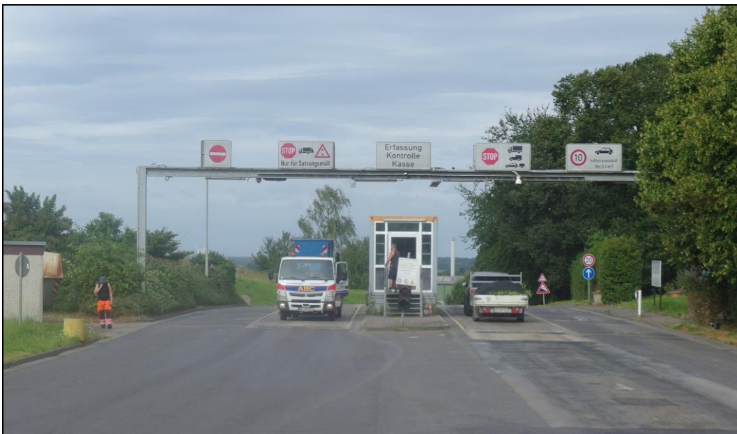
Bild 3: Zufahrtskontrolle Deponie Süchteln
